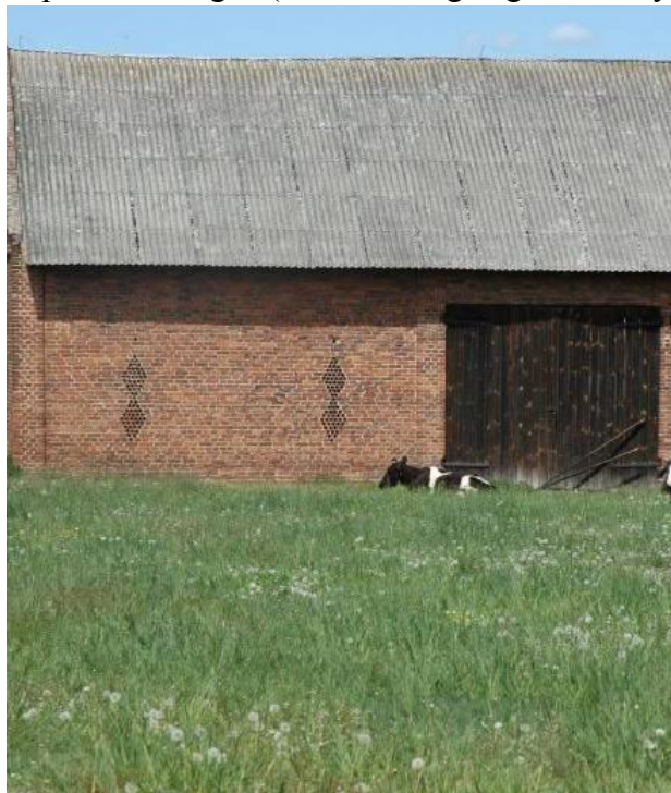
Fot. 2. Pokrycie azbestowe na budynku gospodarczym (fot. A. Zaborowska).
