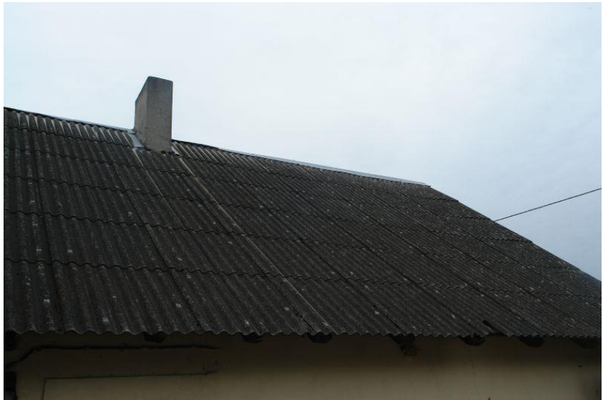
Fot.1. Azbestowy dach na budynku (fot. A. Zaborowska).
