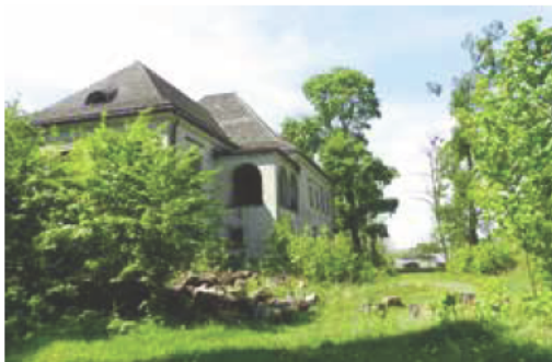
▲ ..... Ruiny dworu w Skotnikach (KKb)
